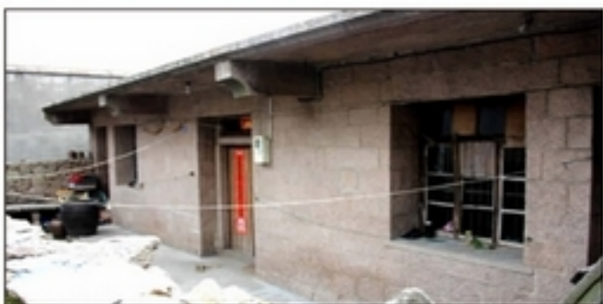
图 14 墙、梁、板皆为石块的石屋
